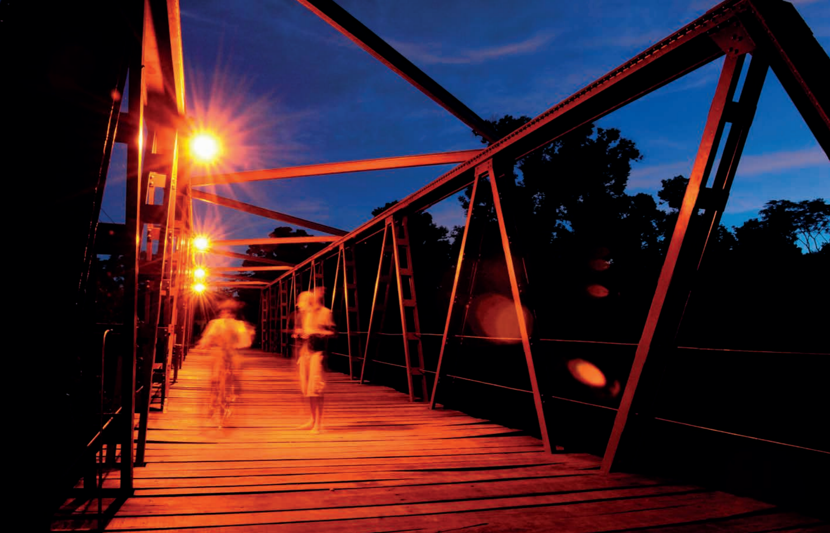
Ponte de ferro, bairro Coxipó da Ponte – Cuiabá.
