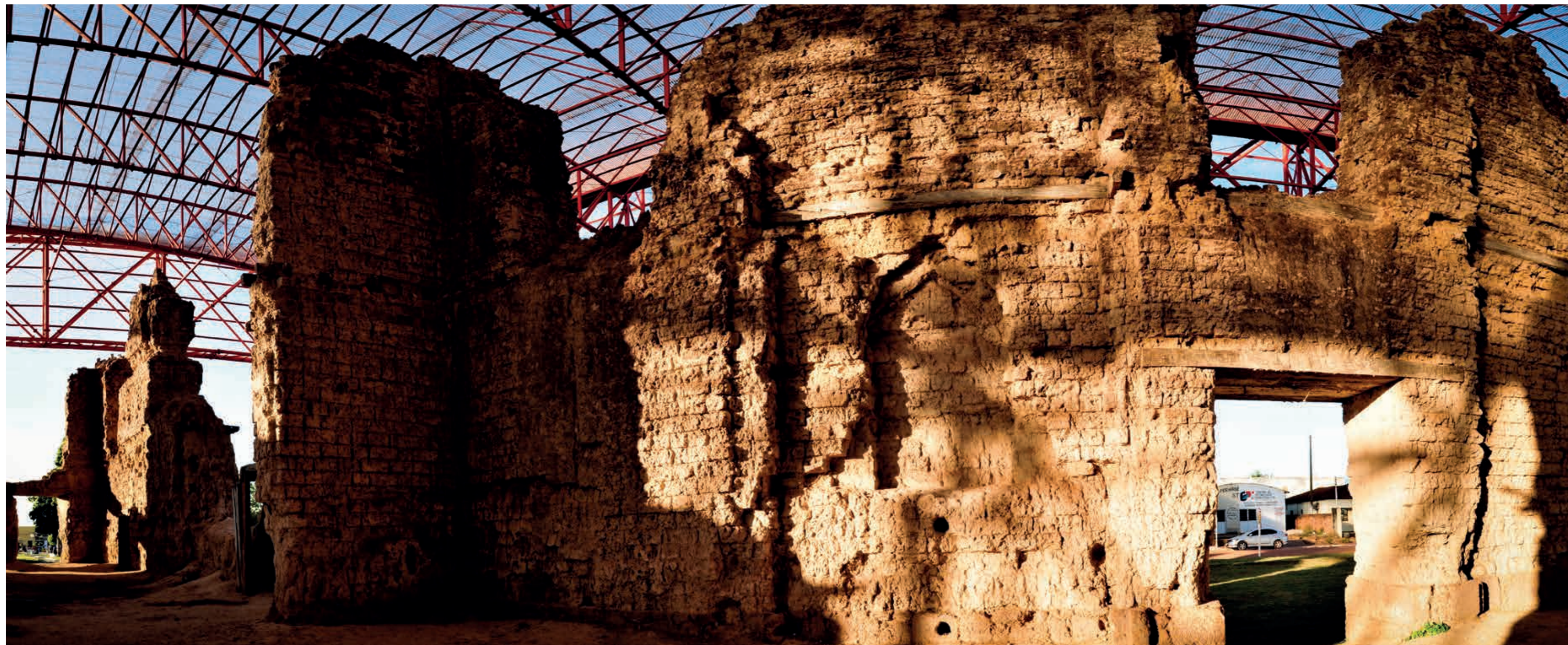
Ruínas da igreja matriz de Vila Bela da Santíssima Trindade.
