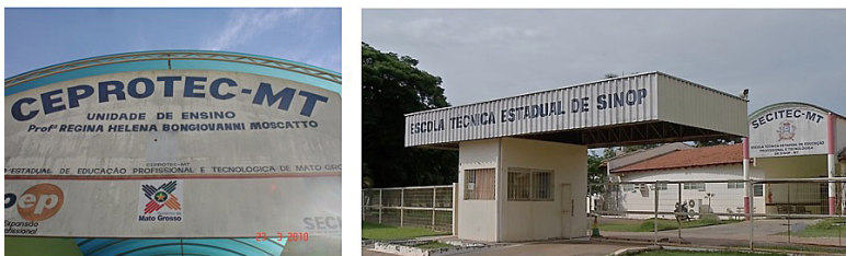
Figura 7 – Fachadas da Escola Técnica em 2004 e atual
